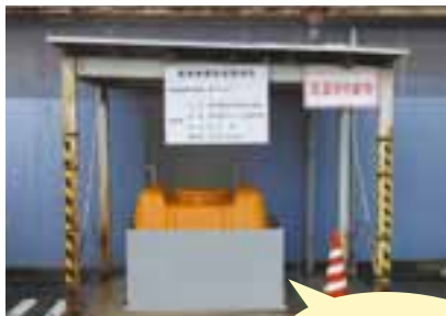
在废碱容器周围设置了围栏，防止泄漏。
