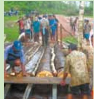
在 Nakha 村修建桥梁（老挝）
