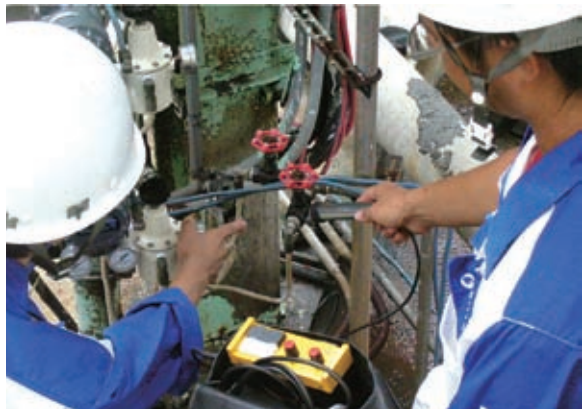
王子制纸株式会社春日井工厂进行的节能巡视 确认是否存在漏气造成的浪费
