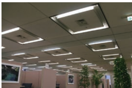
取下部分荧光灯管
